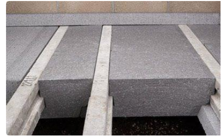
Фиг. 6. Запълване на плоча от полистирол с бетон (Източник: konnyu-beton.hu)
