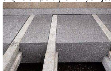
Ilustracja nr 6. Slab filling polystyrene with concrete (Source: konnyu-beton.hu)
