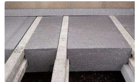
Şekil 6. Polistireni betonla dolduran döşeme (Kaynak: konnyu-beton.hu)
