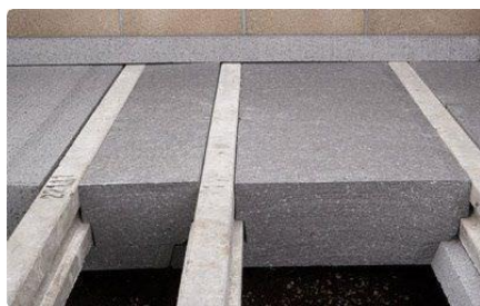
5. Ábra Födémfeltöltés polisztirol betonnal (Forrás: konnyu-beton.hu)
