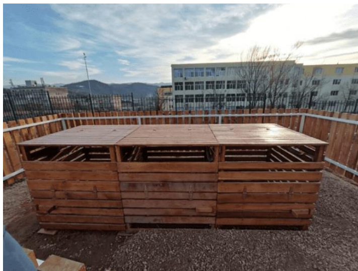
Figura 6. Municipio de Gabrovo, proyecto "Ejecución de un proyecto piloto de demostración en el ámbito de la gestión de residuos en el territorio del municipio de Gabrovo".
